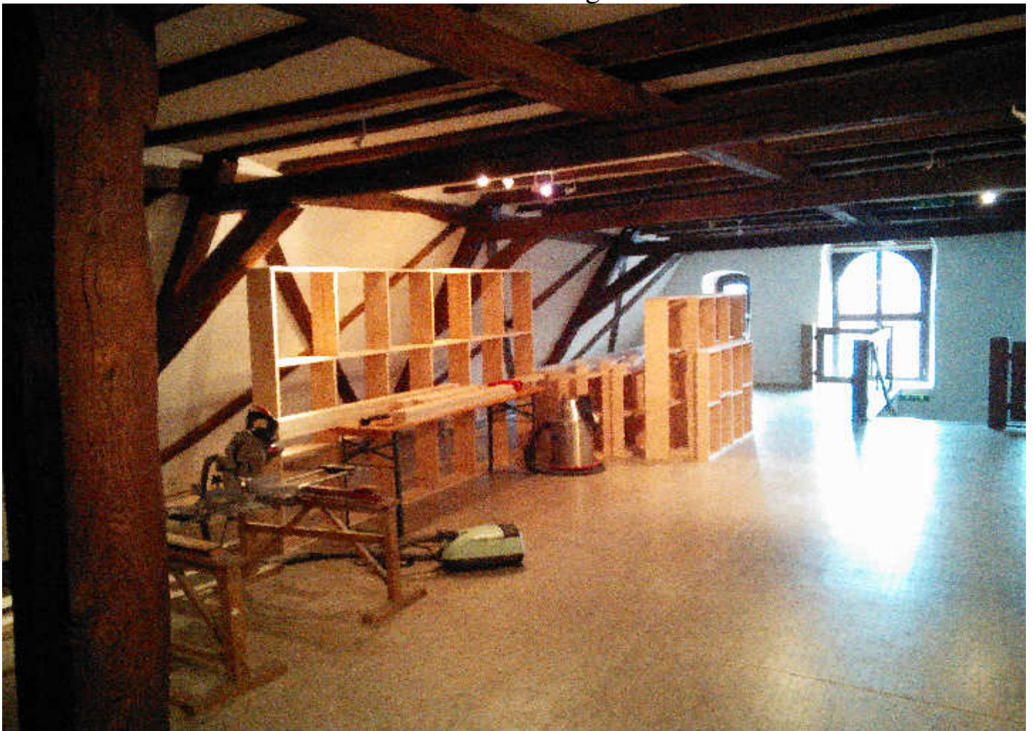
Mit dem Unterbau fängt alles an
